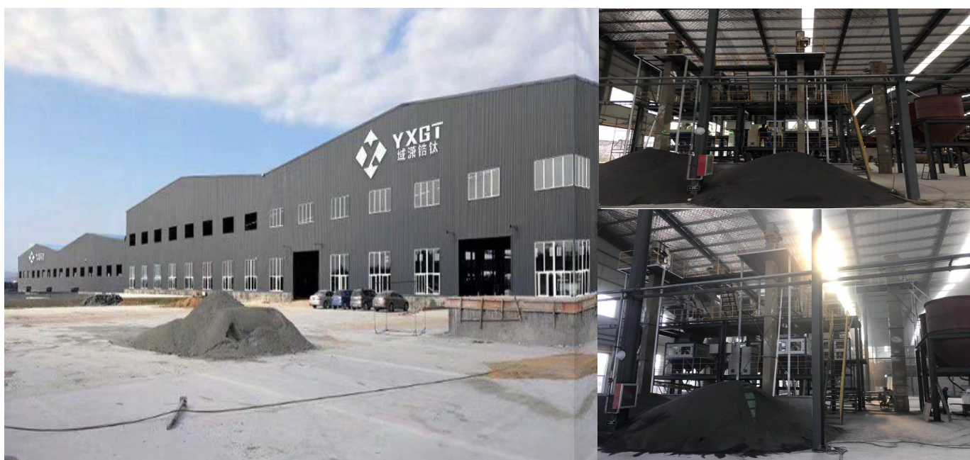
临沂锆钛矿选矿厂及内部生产设备实景
